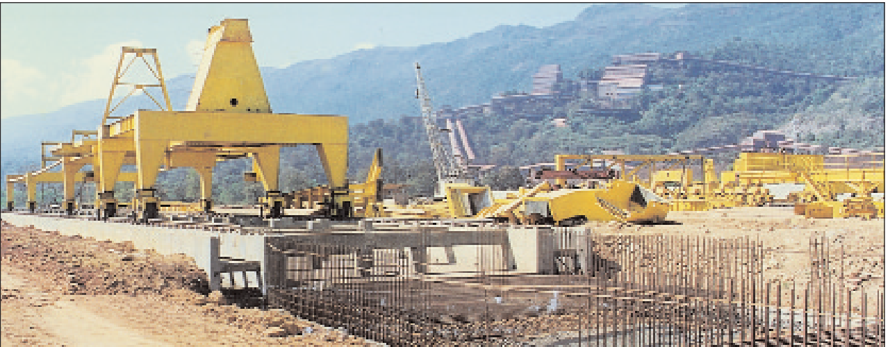
10/11ए परियोजना बैलाडीला में निर्माण कार्य
