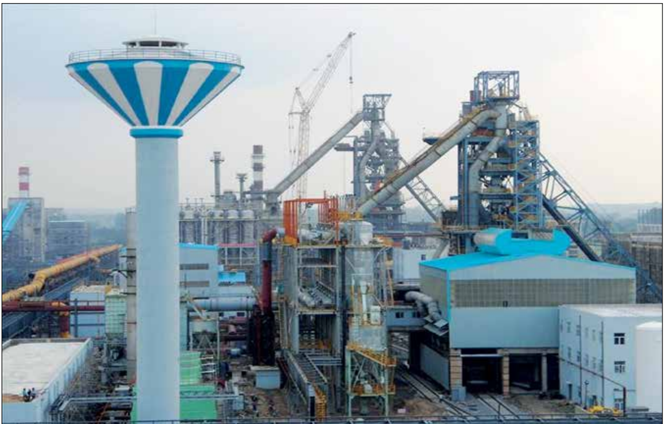
Blast Furnace VEDANTA (ESL STEEL LTD)
