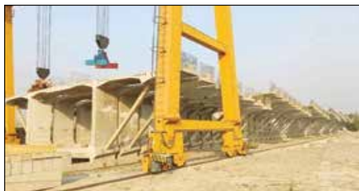
धुबरी पुल का निर्माण स्थल
