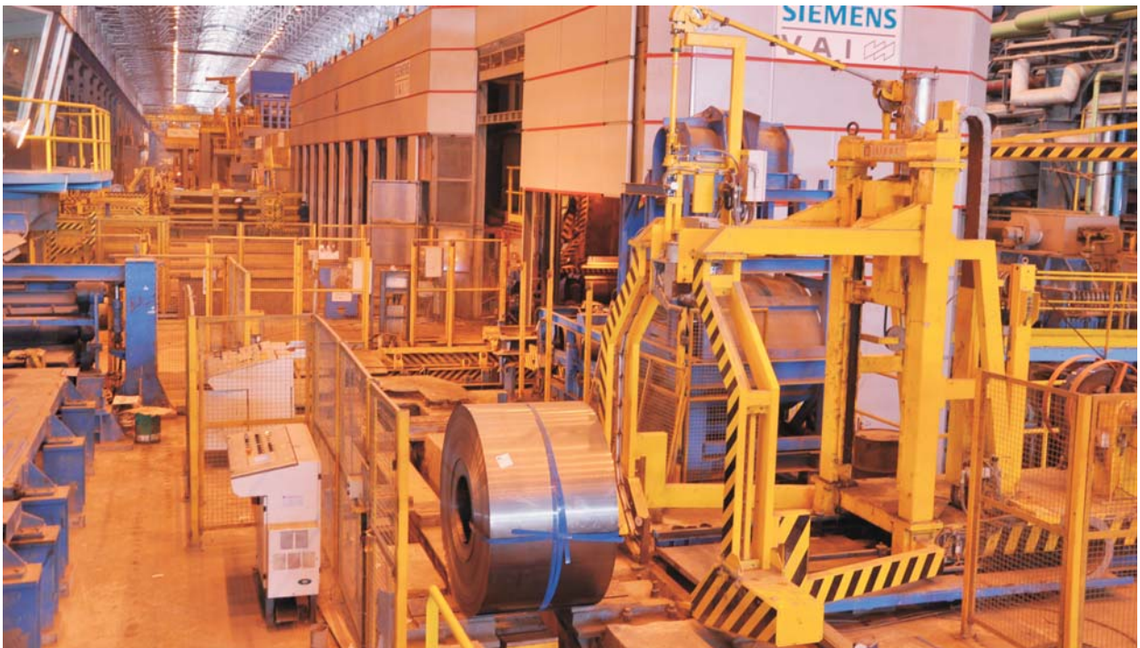
सेल के बोकारो स्टील प्लांट में नई कोल्ड रोलिंग मिल-3
