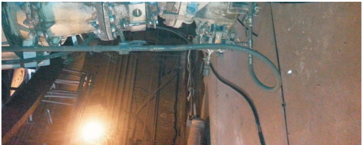
आरआईएनएल के ब्लास्ट फर्नेस 3 में कोक की जगह कुछ पलवेराइज्ड कोयला प्रक्षेपण और फलतः उत्पादन लागत में कमी
