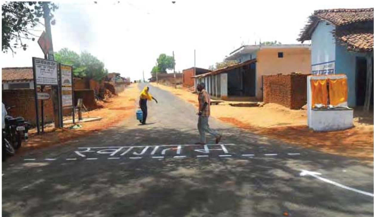
छत्रा जिला, झारखण्ड में एचएससीएल द्वारा प्रधान मंत्री ग्रामीण सड़क योजना के अंतर्गत सड़क निर्माण।
